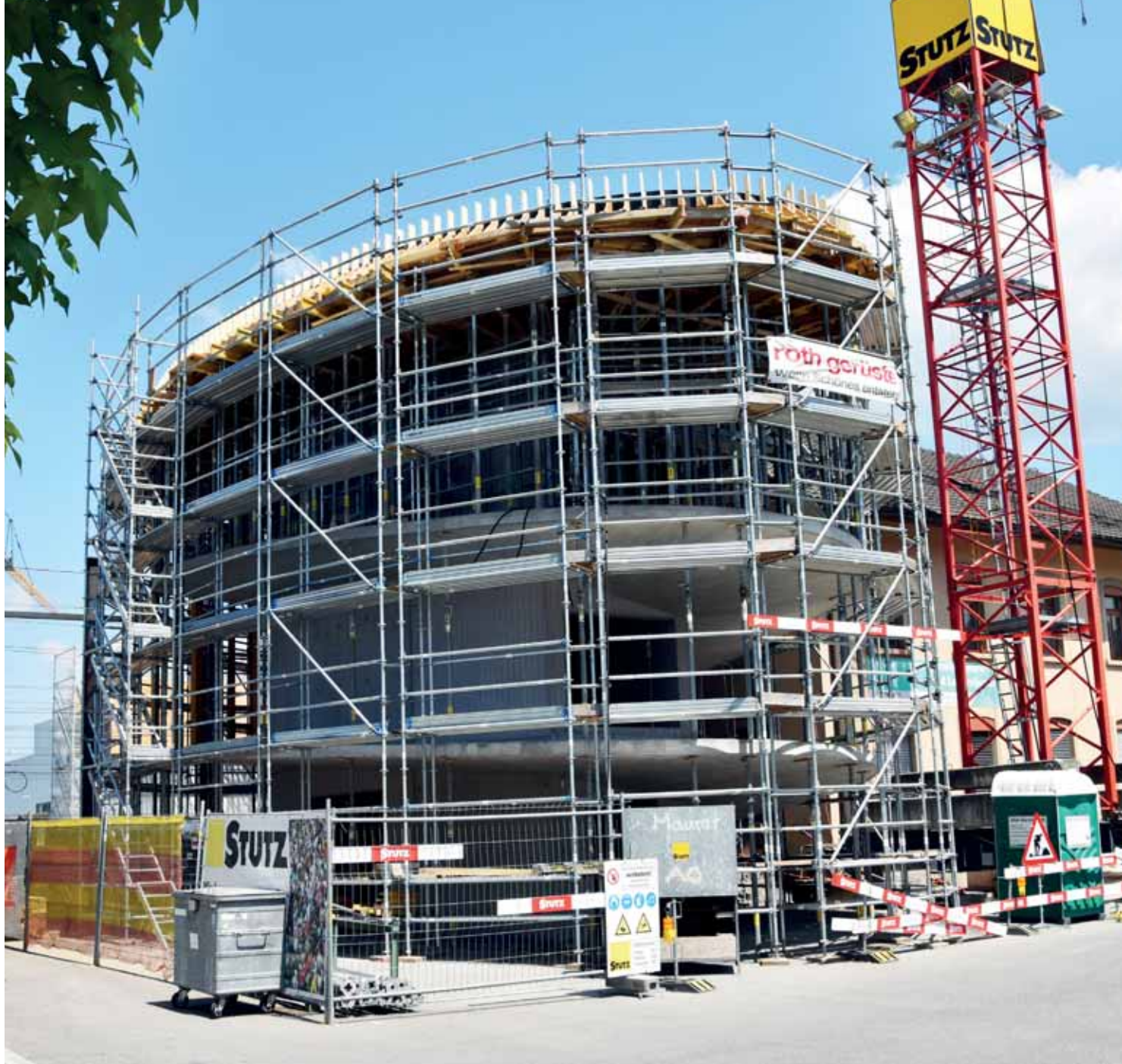
Rohbau Schneckenaufgang zur Passerelle Altfeld im Mai 2020; dank der spiralförmigen Rampe und des integrierten Lifts kann die Passerelle von gehbehinderten Menschen gleichermaßen genutzt werden wie von Velofahrern.
